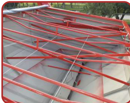
Interior de tolva completamente reforzado. Lateral opuesto a la carga con mayor elevación.
